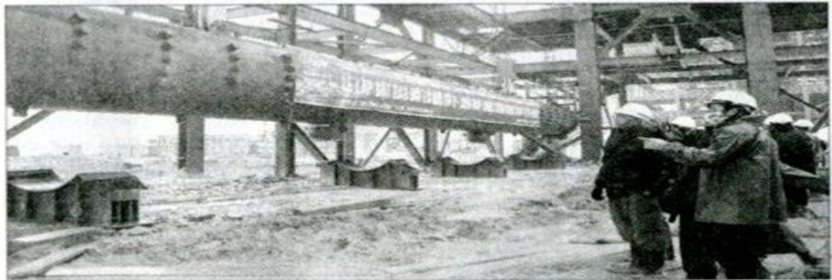
Bao hơi tổ máy số 2 đã được lắp đặt vào vị trí.
